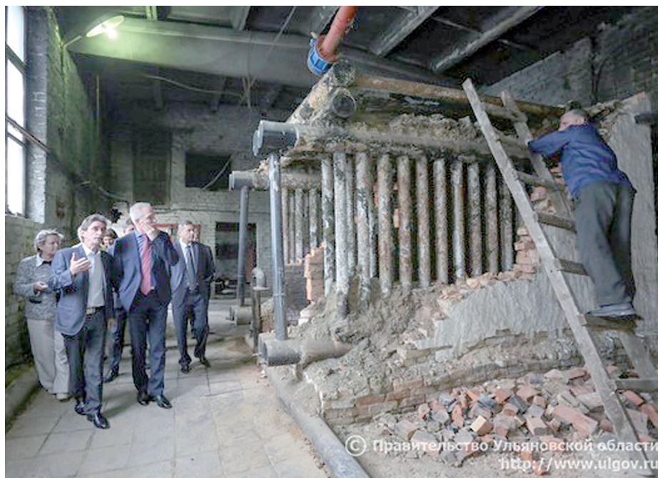
Демонтаж мазутных котельных идет полным ходом.
